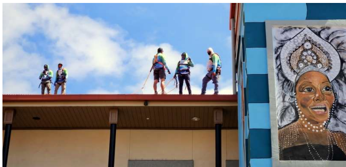
delavci na strehi, vsi privezani z varnostnimi pasovi
